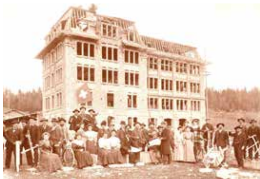
Le bâtiment principal actuel lors de sa finalisation en 1907.
